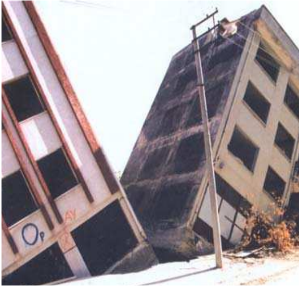
Şekil 3. Sıvılaşmanın gözlenen etkileri
