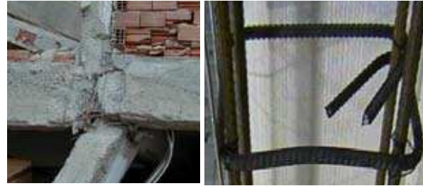
Düğüm noktasında kolona etriye konulmamış
