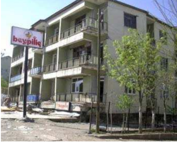
Şekil 21. Komşu Katlar Arası Rijitlik Düzensizliği (Yumuşak Kat) Etkisi
