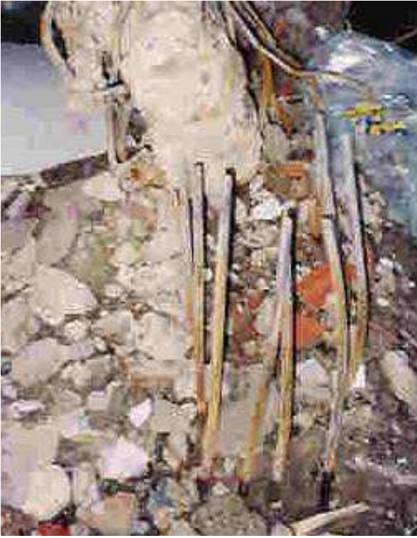
Şekil 5. Boyuna donatıların bindirmeli eklerinin yetersiz olması
