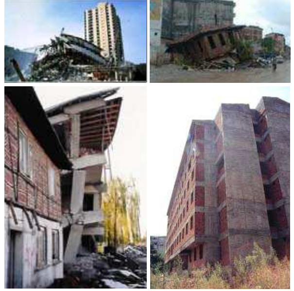
Şekil 14. Farklı türde taşıyıcı sistemlerde deprem hasarları
