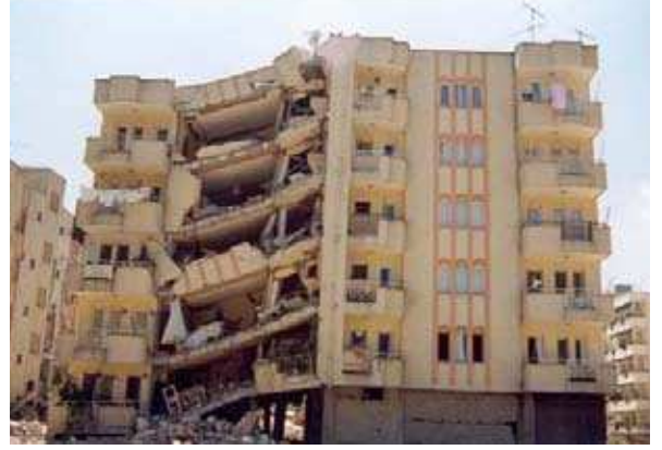
Yumuşak kat nedeniyle göçme (1998 Ceyhan)
