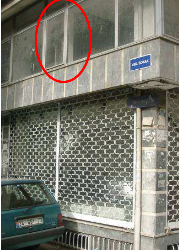
Şekil 7. Üst katlarda mevcut olup, zemin katta kesilen kolon
