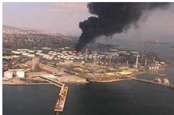
Şekil 13. 1999 Marmara depremi sırasında Tüpraş'ta çıkan yangın.
