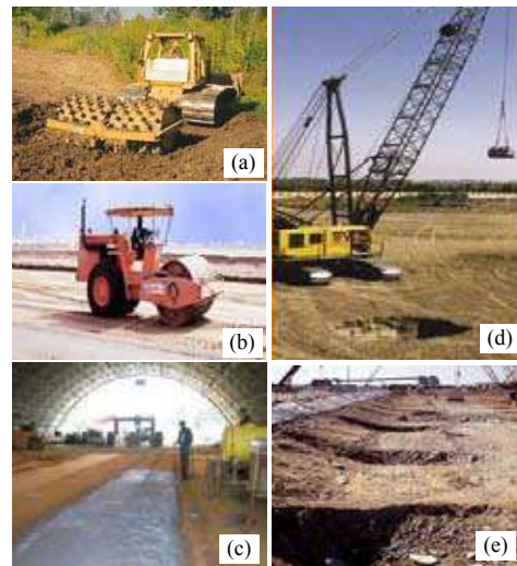
Şekil 13. a,b) Silindirle kompaksiyon c) bitümle stabilizasyon d,e) dinamik konsolidasyon
