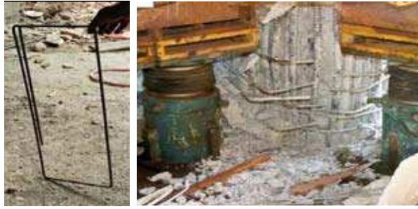
Kancaları 135 derece kıvrılmayan ve etriyelerin sıyrılarak açılması
