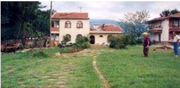
17 Ağustos 1999 depreminde Kuzey Anadolu Fayına (KAF) daha yakın bina ayakta dururken diğerleri yıkılmış.
