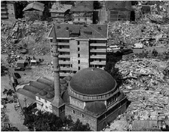
17 Ağustos 1999-Gölçük, Altında yumuşak kat olan yeni inşa halindeki bina ile yanındaki caminin minaresi bile sapsağlam yerinde dururken etrafındaki binaların neredeyse tamamı yıkılmış.
