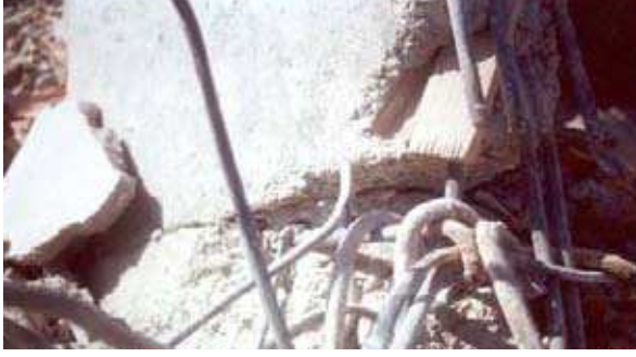
İçinde tahta parçası olan beton
